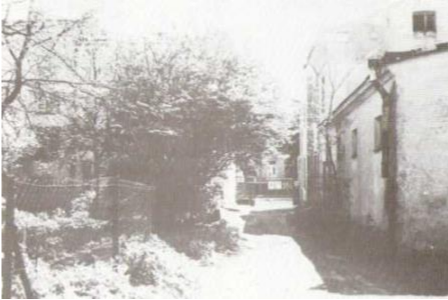
Budynki tomaszowskiego PUBP
