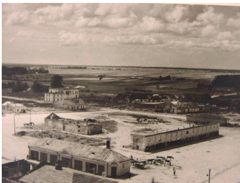
Widok spalonego rynku. Spalony ratusz obok budynek parterowy, w którym było 15 sklepów - biłgorajskie sukienice, w oddali spalona synagoga
